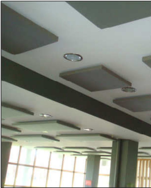
Foto 1 – Painéis acústicos nos teto da sala de refeições da unidade alimentar da ESE
